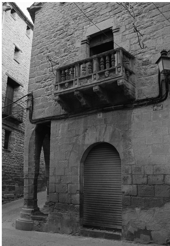
FIGURA 1. Casa del Justícia. A la columna que fa cantonada es pot apreciar el baix relleu.
